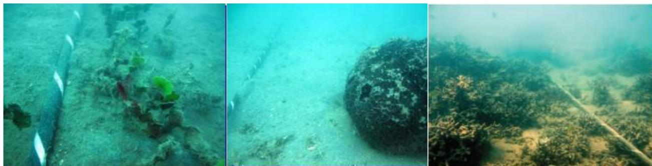
Egalement, la pose de coquille articulée se faisant avec des plongeurs, il pourra être évité les colonies coralliennes malgré le rayon de courbure limité de 4 mètres (**voir photos ci-dessous source : A2EP / BioIMPACT, 2011**).
